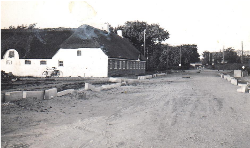
Der bliver anlagt fortov og en asfalteret vej. Viadukten i baggrunden
